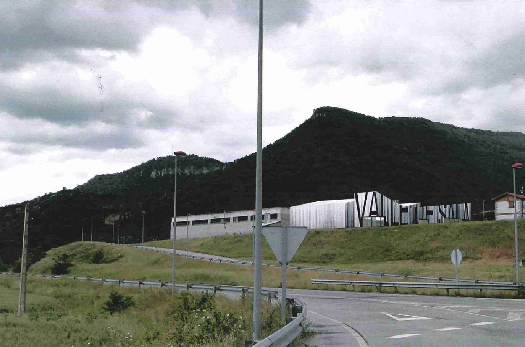
VISTA DESDE EL ACCESO AL POLÍGONO INDUSTRIAL DE ICIZ
